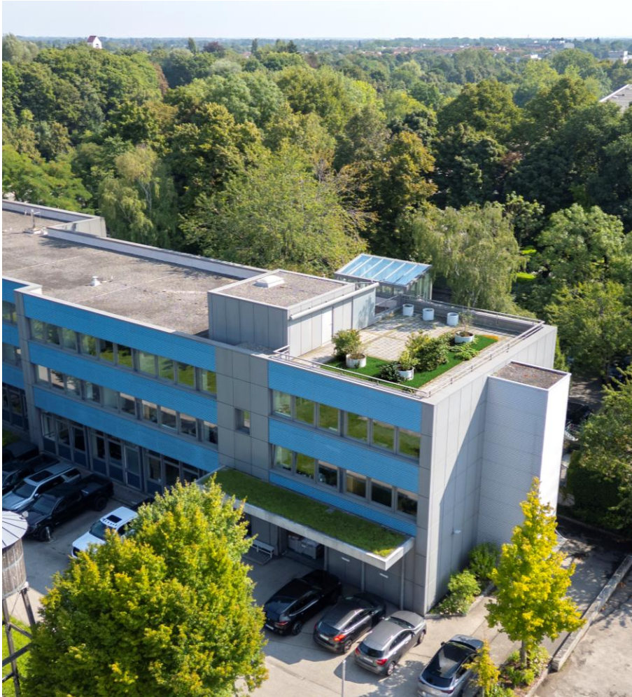
Luftaufnahme mit Ansicht der Dachterrasse
