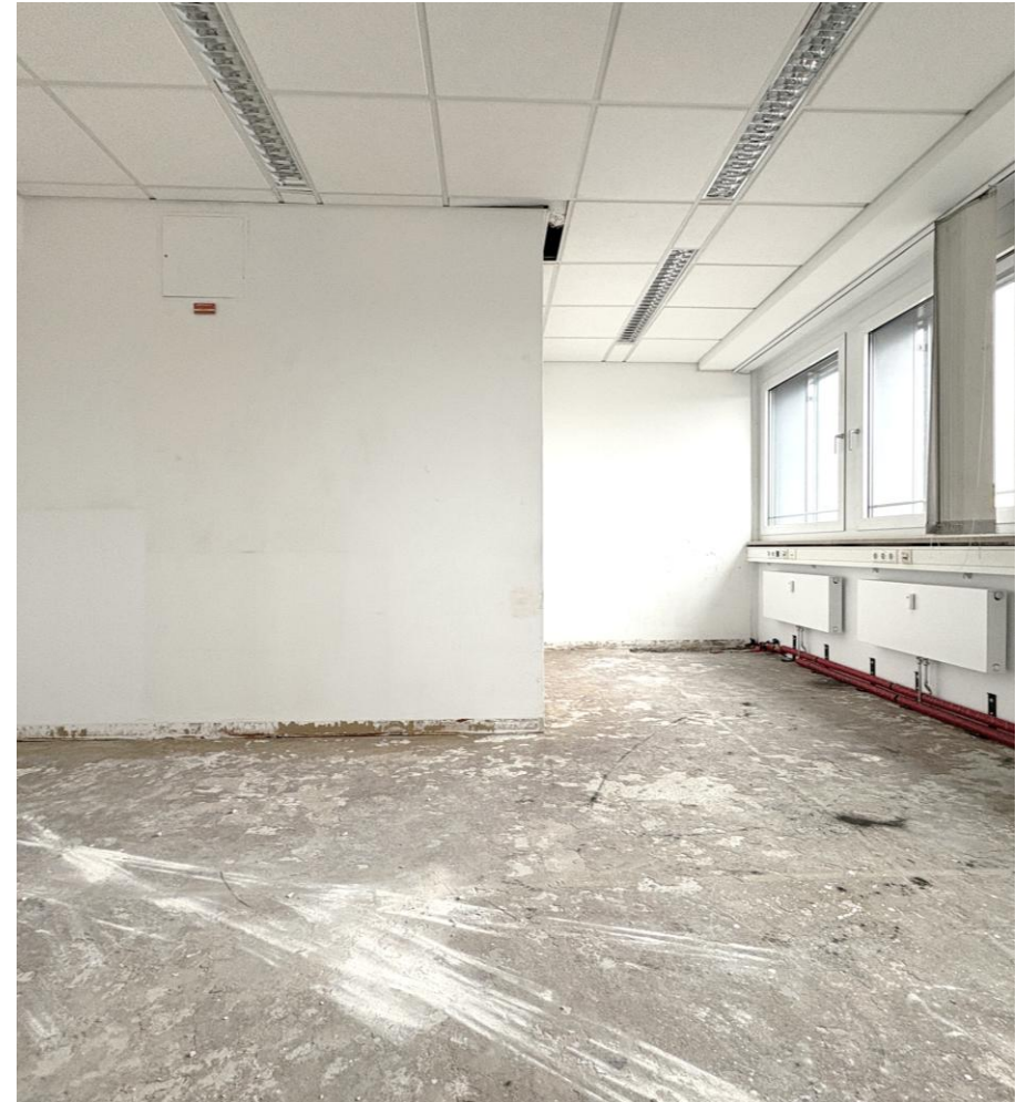
Bürofläche im Edelrohbau
