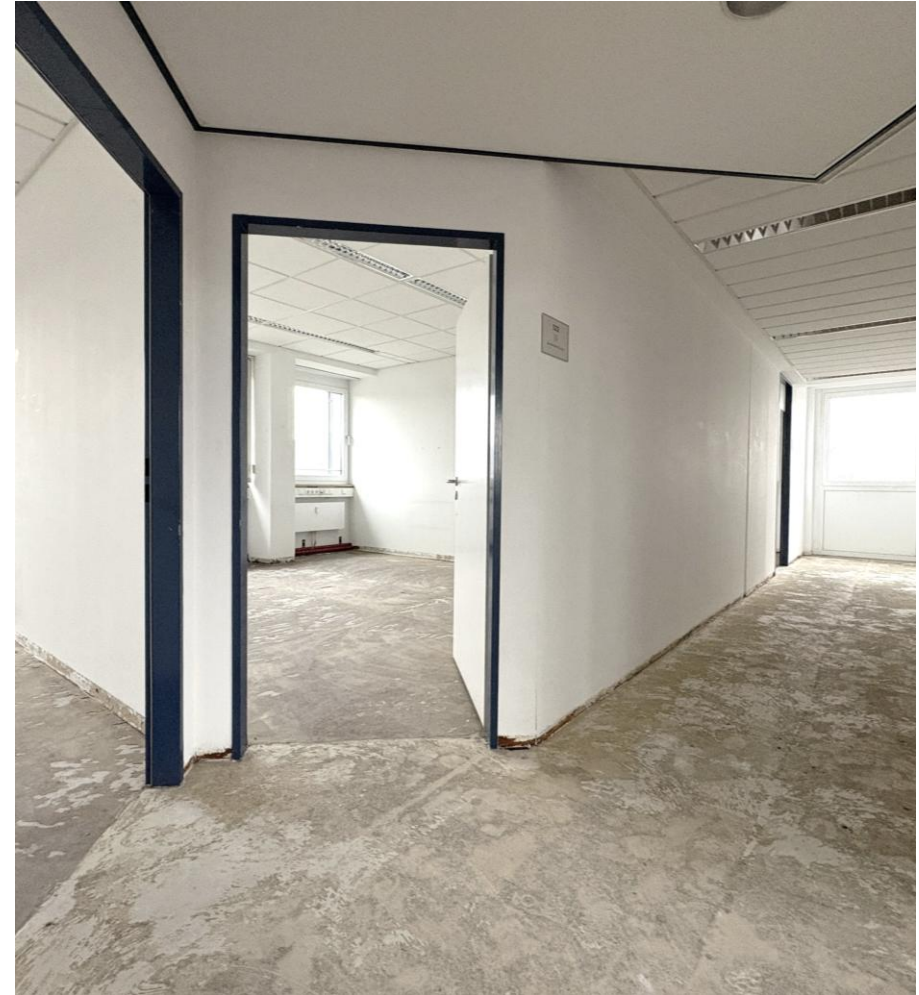
Flur im Edelrohbau
