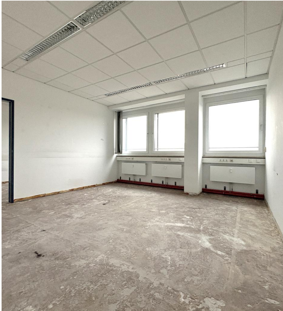
Bürofläche im Edelrohbau
