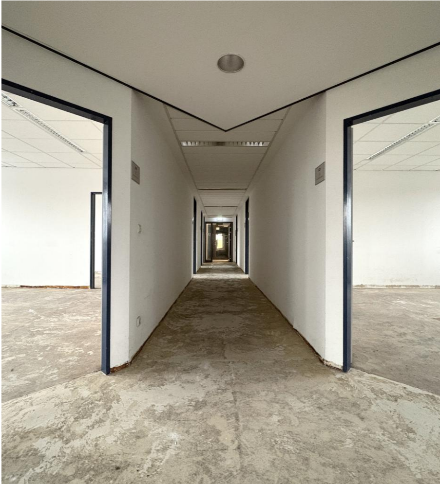
Flur im Edelrohbau
