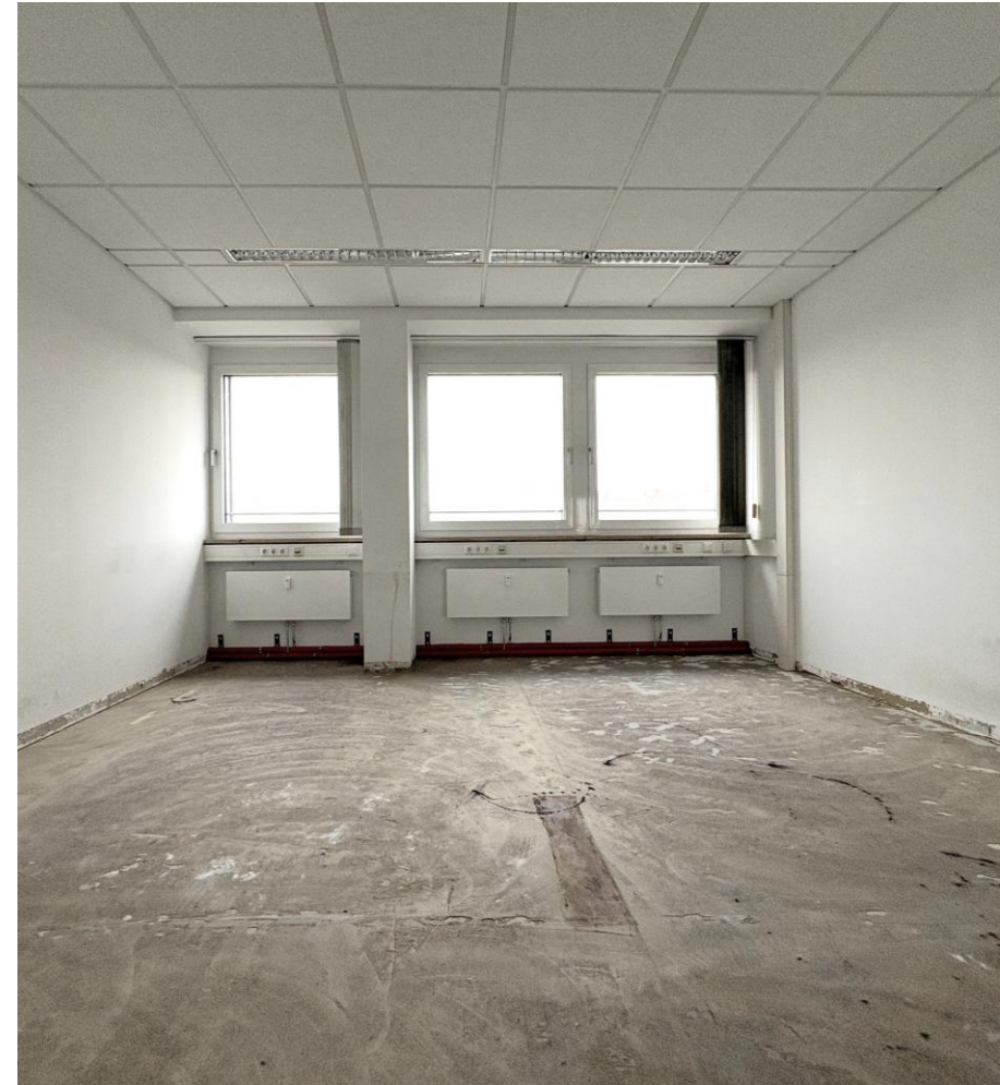
Bürofläche im Edelrohbau
