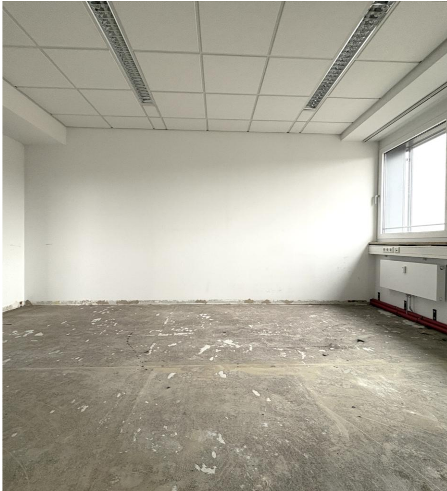
Bürofläche im Edelrohbau
