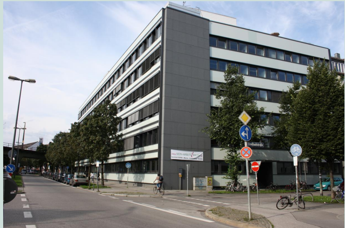
Gebäudeansicht Pilgersheimer Straße Ecke Freibadstraße
