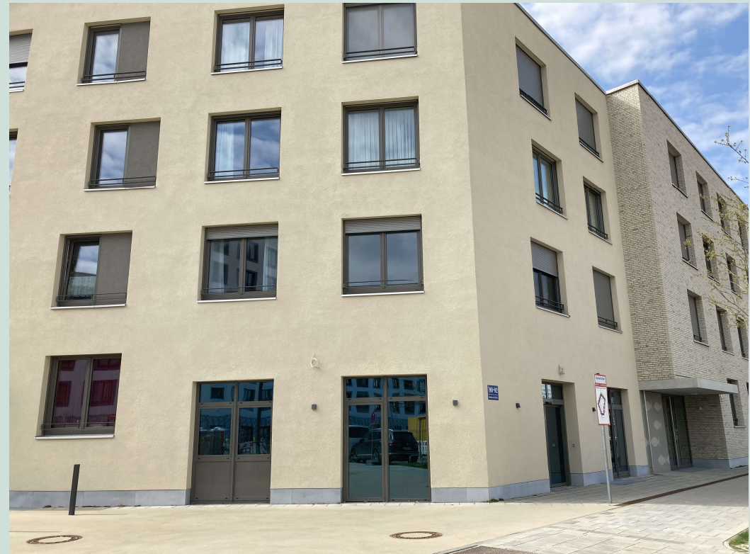
Bilder Außenansicht Gebäude Hermine-von-Parish-Straße 78
