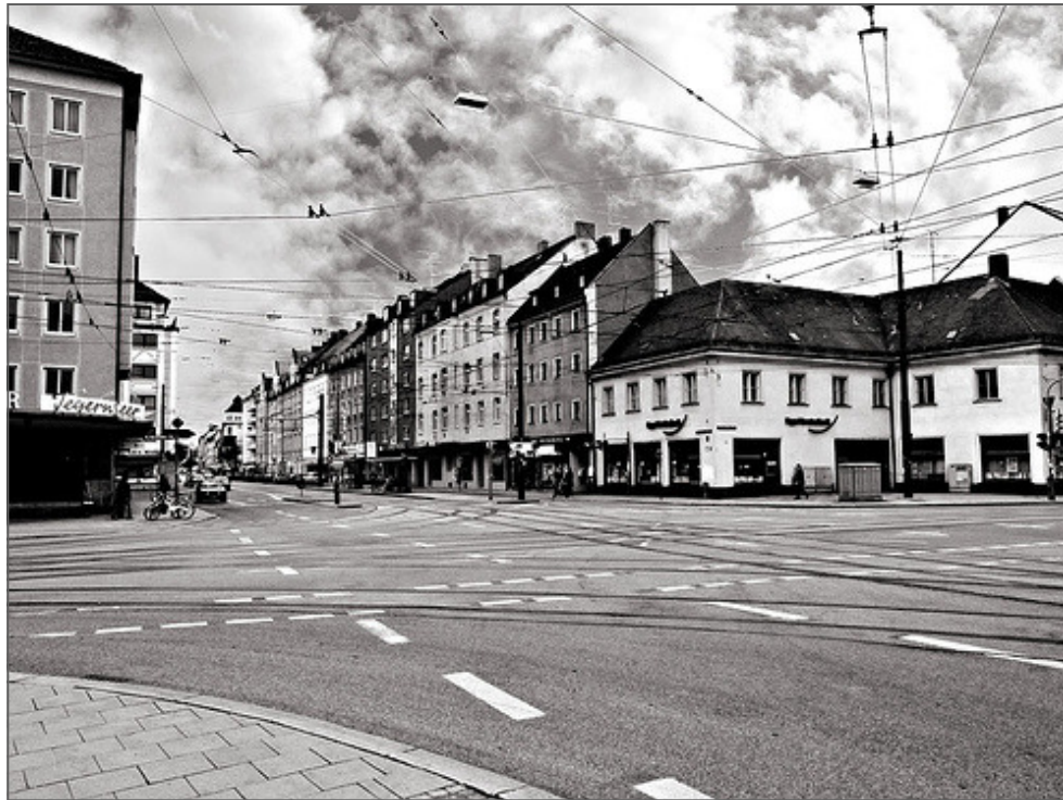
Eingangstor Giesing vor der Sanierung
